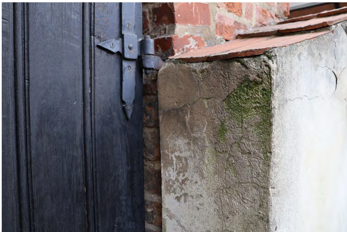
Stan zachowania powierzchni tynkowanych. Widoczne spękania grożące odpadnięciem, zawilgocenia, itp. Kraków, 2025, Fot. I. Michalik
