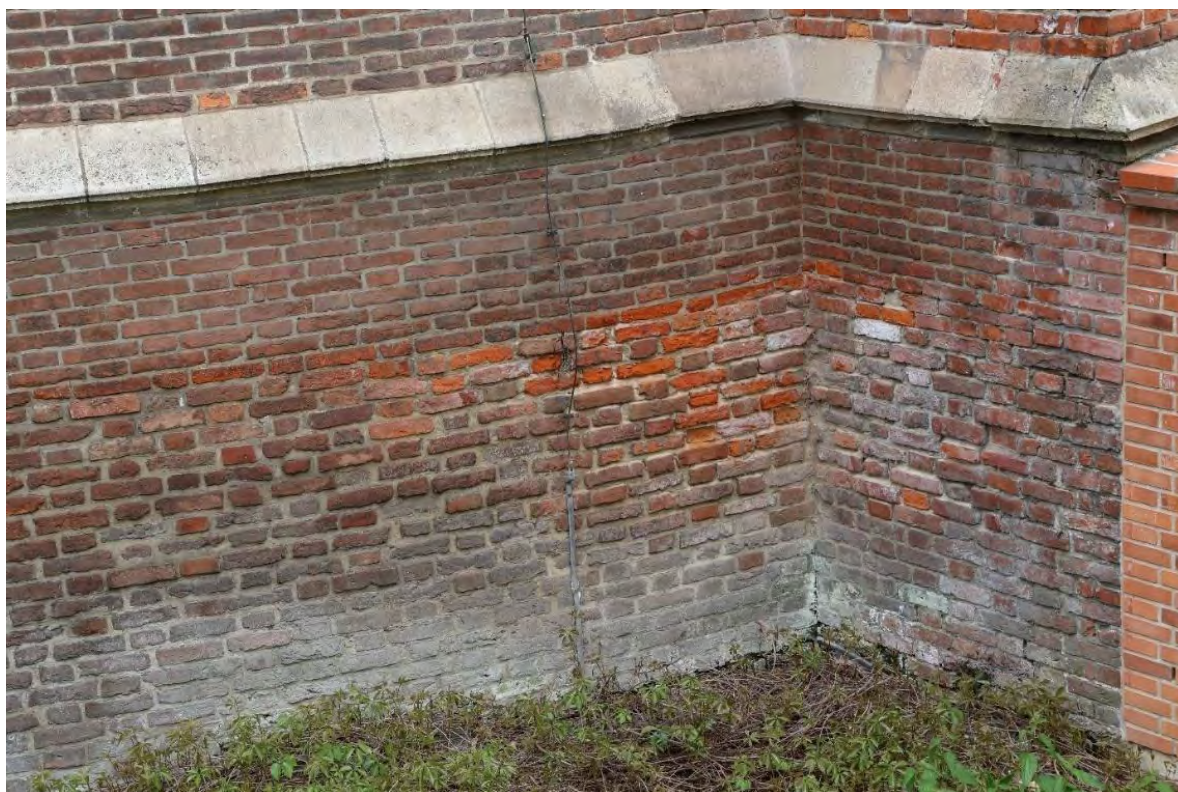
Widoczne na zdjęciu są: gipsowy osad, degradacja lica cegieł oraz zacieki. Kraków, 2025, Fot. I. Michalik
