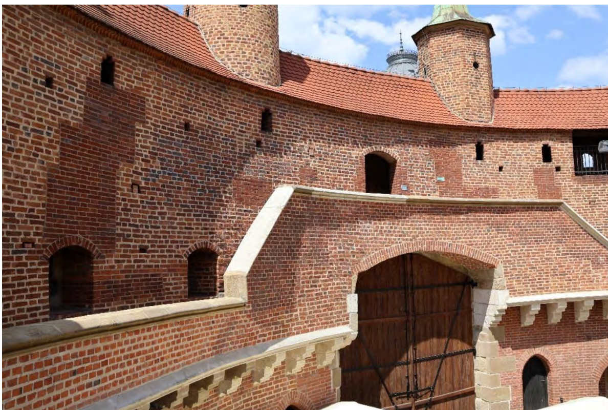
Widoczne przemurowania wtku ceglanego pochodzące z poprzednich prac konserwatorskich. Ściana północno-zachodnia wewnętrzna. Kraków, 2025, Fot. I. Michalik
