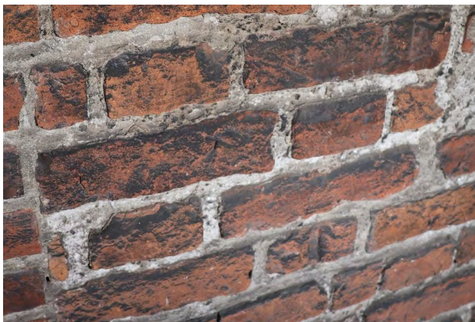
Widoczne zanieczyszczenia pochodzące z powietrza widoczne na ścianach chodnika wewnętrznego. Kraków, 2025, Fot. I. Michalik
