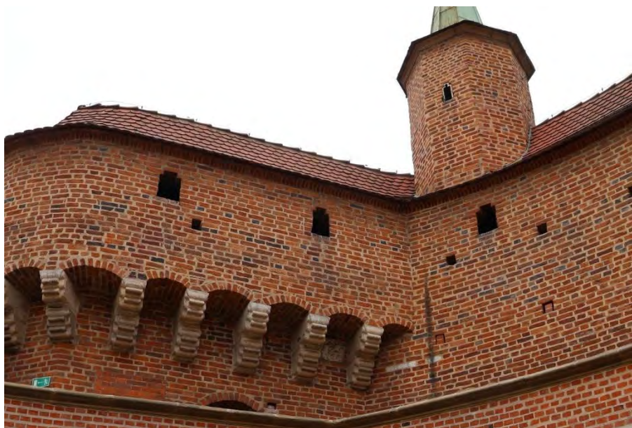
Widoczne zanieczyszczenia pochodzące z powietrza widoczne na ścianach chodnika wewnętrznego. Kraków, 2025, Fot. I. Michalik
