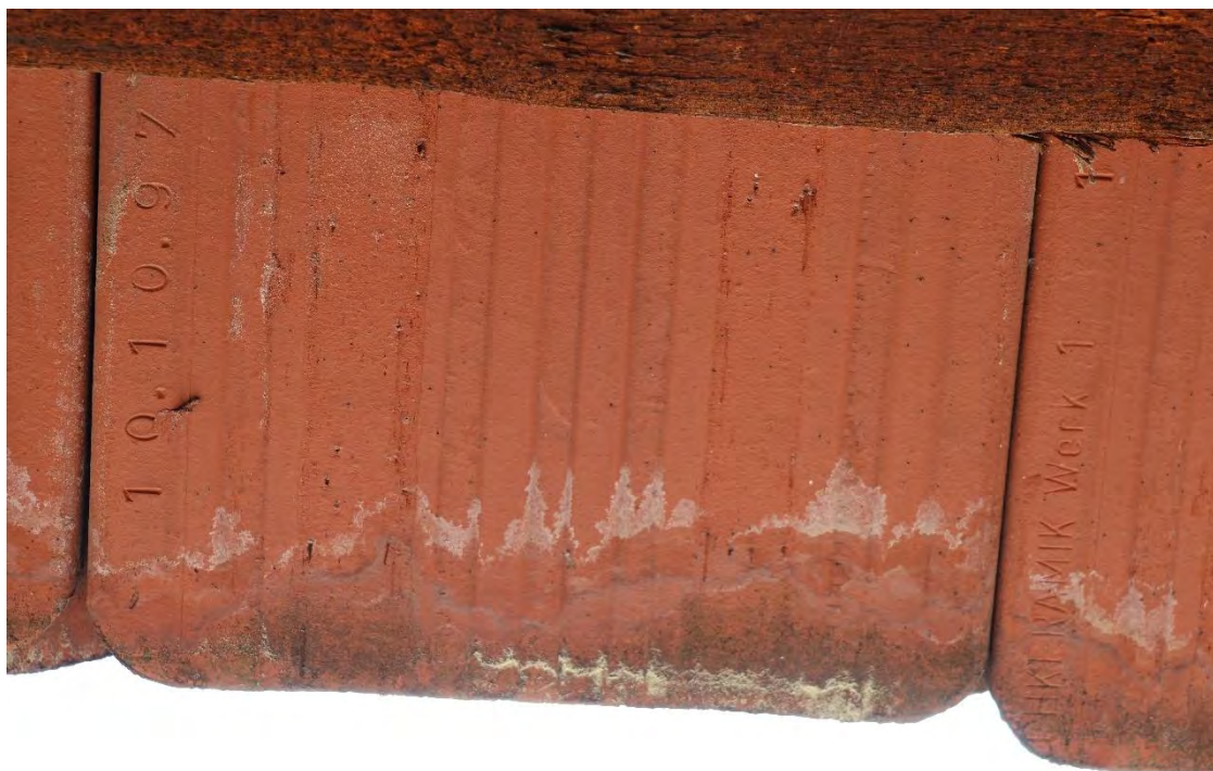
Wtórne pokrycie dachowe z lat 90-tych XX wieku oraz detal dachówki z datą produkcji (?) Kraków, 2025, Fot. I. Michalik
