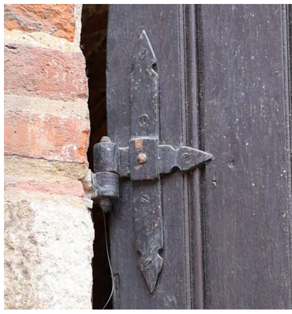
Stylizowane wtórne klamki i zamki stolarki drzwiowej, przykład rzygacza oraz wtórny historyczny zawias stolarki drzwiowej. Kraków, 2025, Fot. I. Michalik
