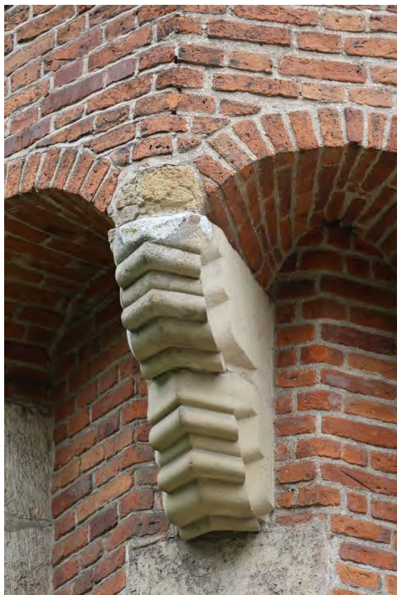
Po lewej: Widoczne ubytki form kamiennego detalu architektonicznego. Barbakan od strony południowej i południowo-wschodniej, Kraków, 2025, Fot. I. Michalik
