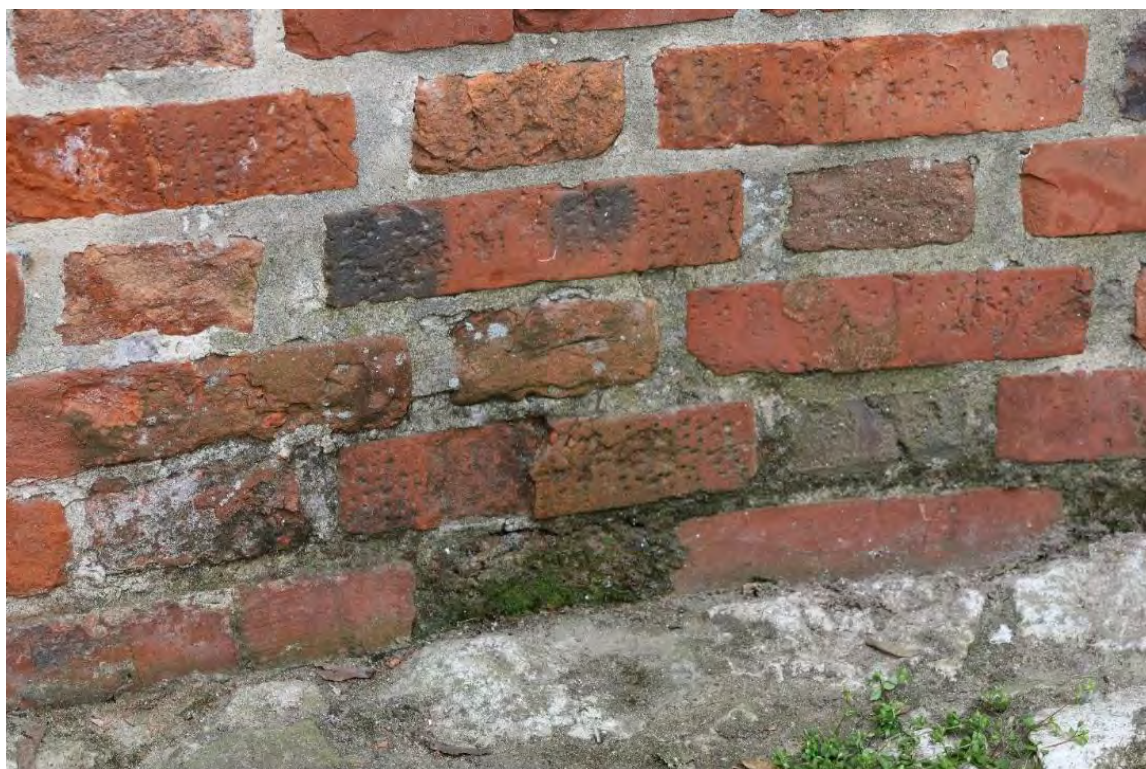
Wątek ceglany dolnej części murów zewnętrznych (poniżej kamiennego gzymsu), od strony północnej. Widoczna obecność nawarstwień pochodzenia biologicznego. Kraków, 2025, Fot. I. Michalik
