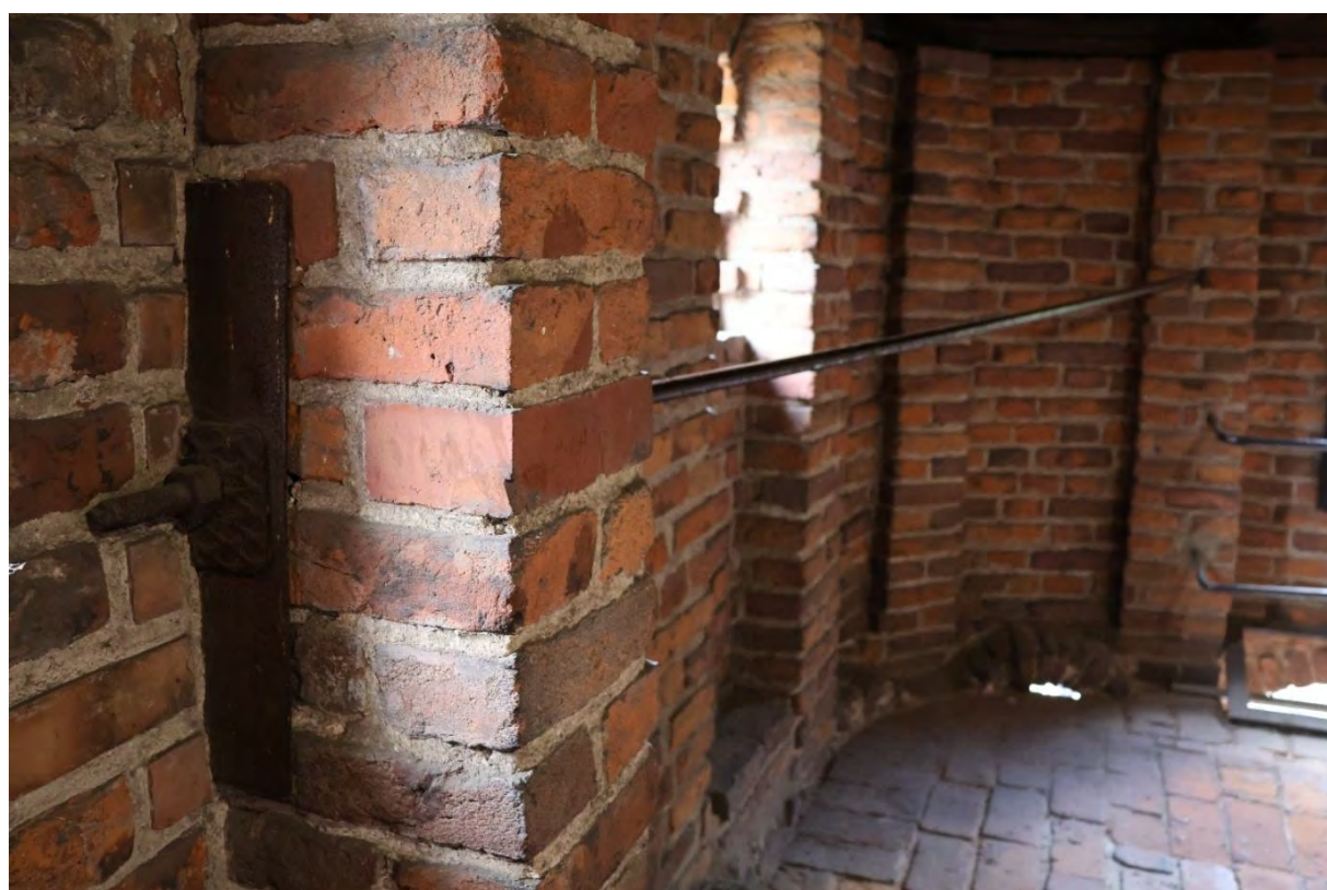
(Na górze) Wtórna barierka przy zejściu na parter. (Na dole) pręt spinający mury w chodniku strzeleckim pierwszego piętra przy południowo-wschodnim narożniku. Kraków, 2025, Fot. I. Michalik
