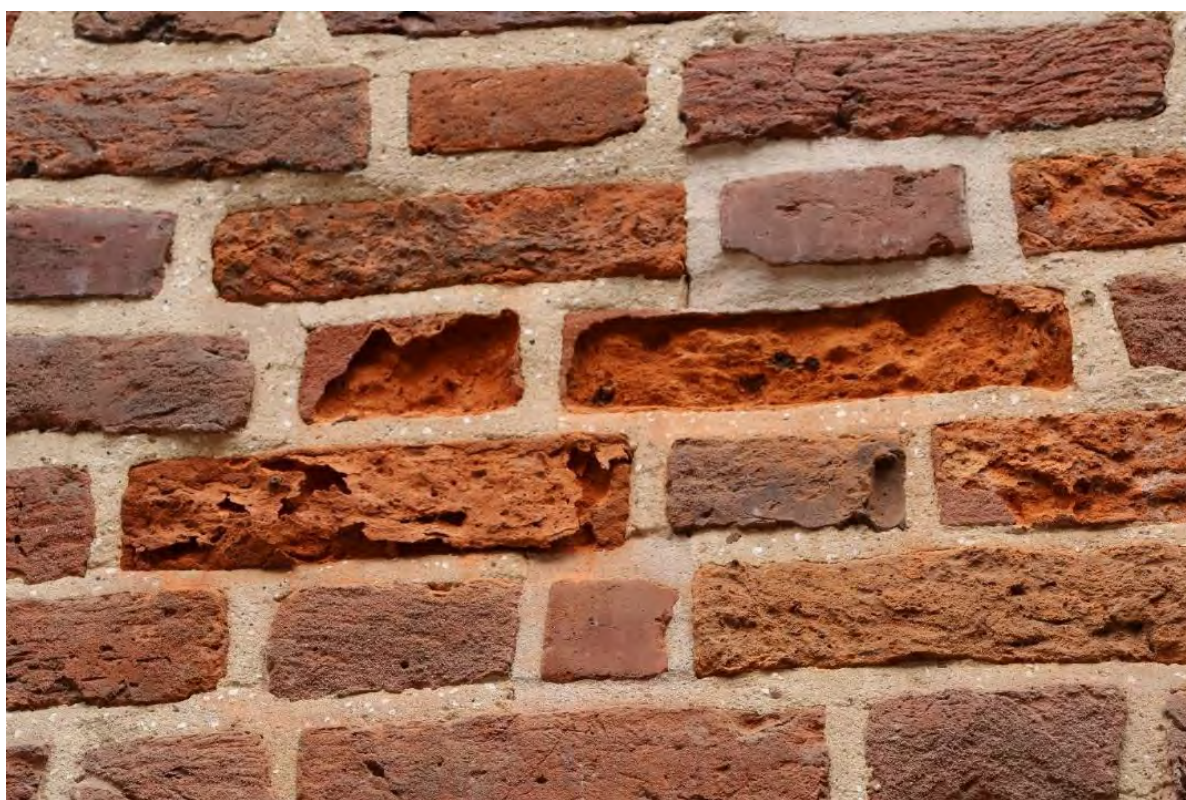
Widoczna na zdjęciu jest degradacja lica cegieł powodowana wypłukiwaniem i wietrzeniem materiału.. Kraków, 2025, Fot. I. Michalik
