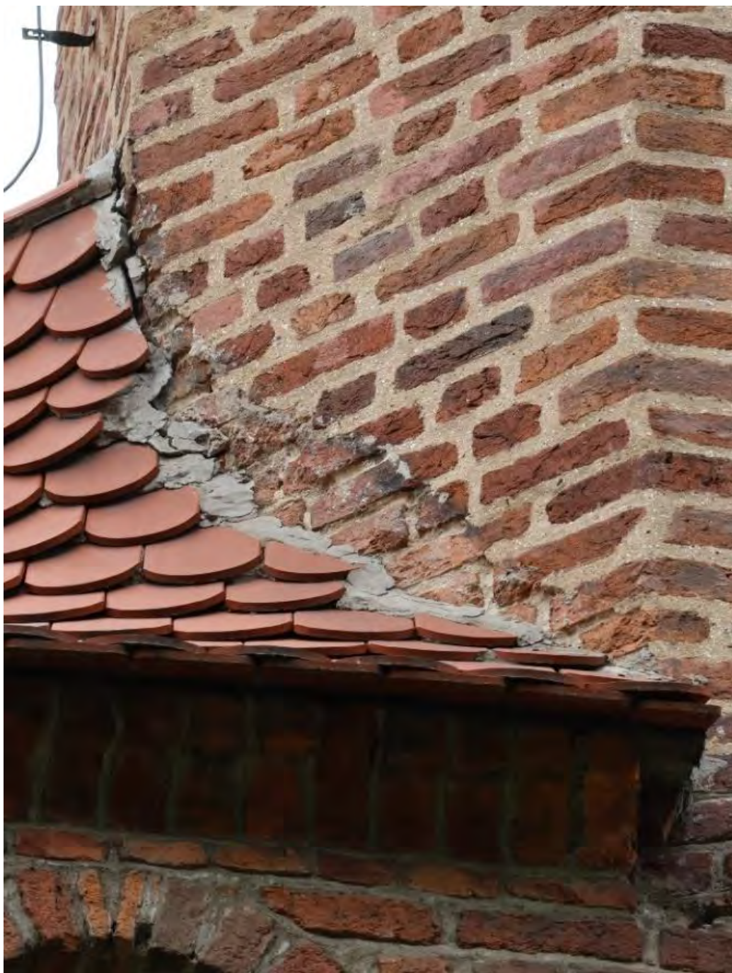
Widoczna degradacja cegieł wynikająca z obecności zaprawy cementowej uszczelniającej dachówkę na styku z wieżą. Kraków, 2025, Fot. I. Michalik
