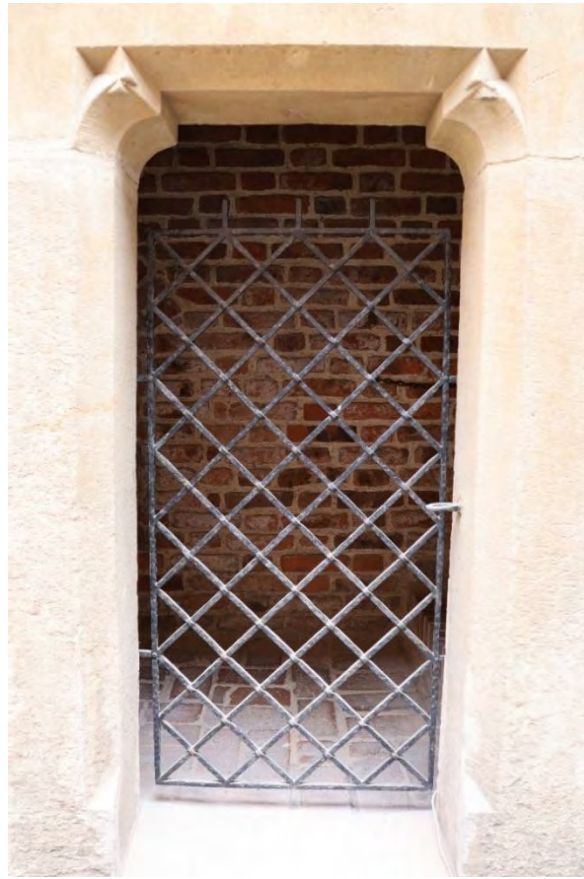
(L) Karta otworu strzelniczego wprowadzona wtórnie w celach bezpieczeństwa. (P) Krata otworu drzwiowego w szyi Barbakanu, ściana wschodnia. Kraków, 2025, Fot. I. Michalik
