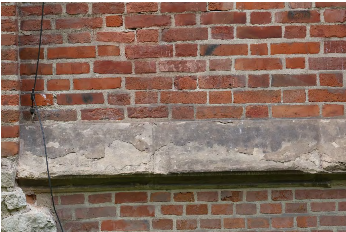
Kamienny gzyms kordonowy z widocznymi oznakami dezintegracji. Kraków, 2025, Fot. I. Michalik
