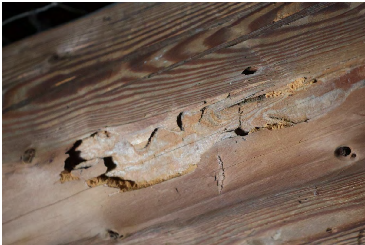
Ślady żerowania drewnojadów w belkach więźby dachowej. Kraków, 2025, Fot. I. Michalik
