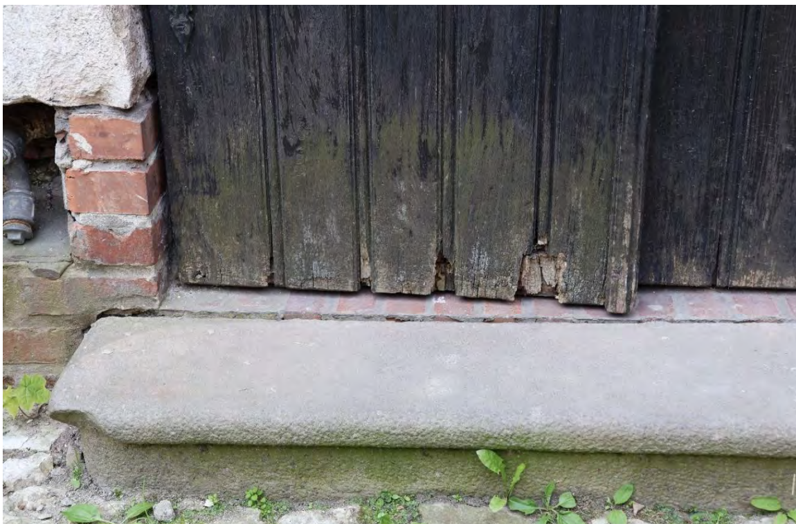
Stan zachowania stolarki drzwiowej, widoczne uszkodzenia drewna oraz nalot mikrobiologiczny. Kraków, 2025, Fot. I. Michalik
